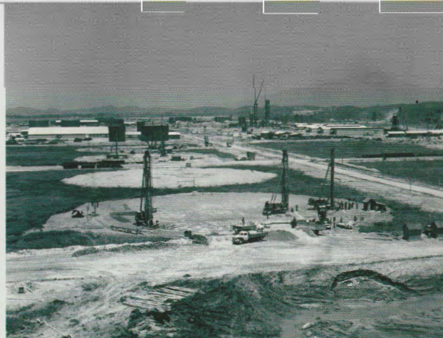
A refinaria Duque de Caxias, no Rio, construída sobre um manguezal.
